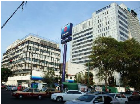
右側メキシコ電話会社の本社ビルの一部と、左側は小生が勤めている雑居ビル
